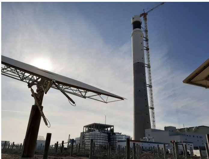
Abb.2: Solarturm und Heliostat
